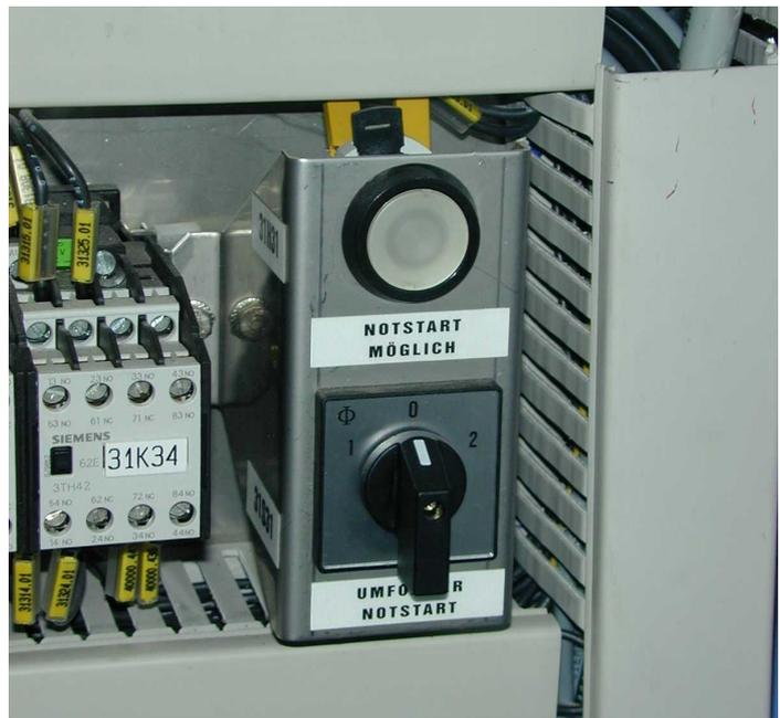
Bild 4: Umformer-Notstart (Geräteschrank 326)
